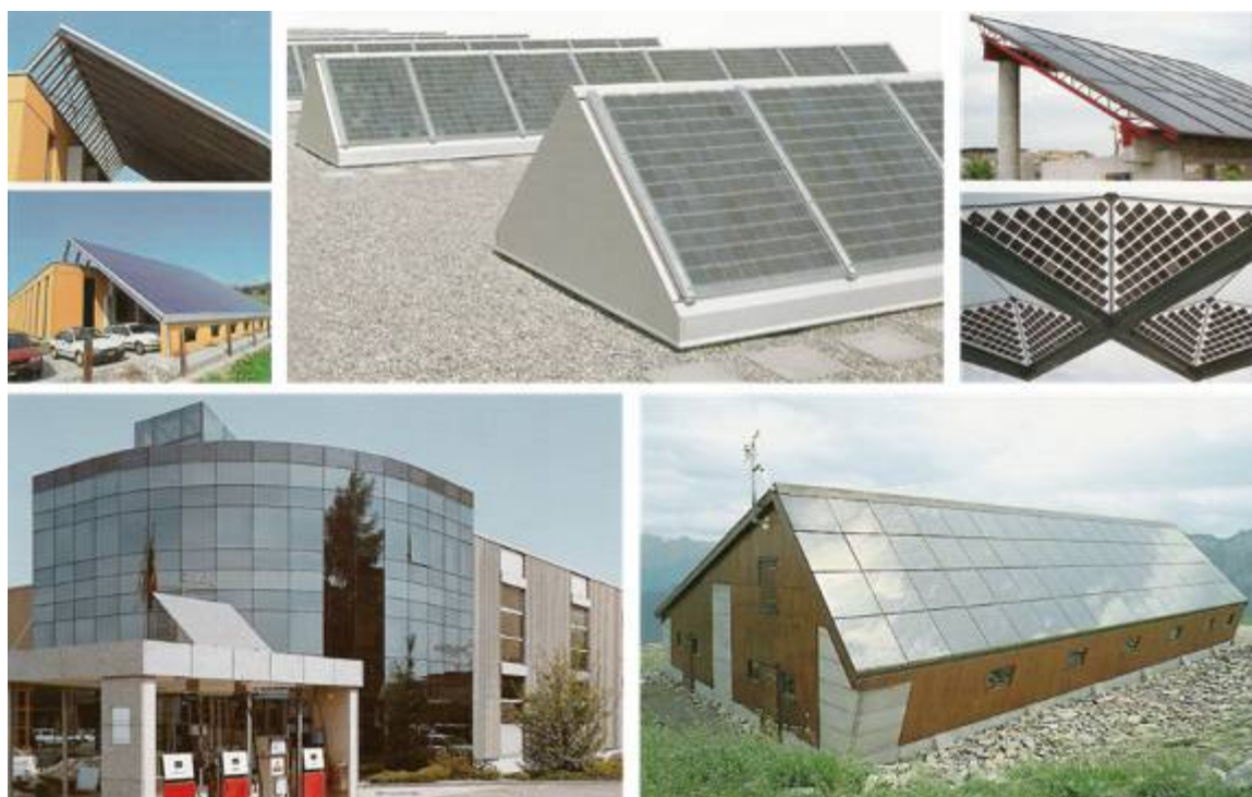
圖表 5 與建築物融為一體的各式 BIPV 模組[11]。
